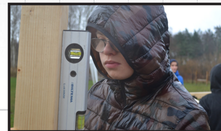
Sebastian Stenhammar kontrollerar att väggen blir rak med vattenpasset.
